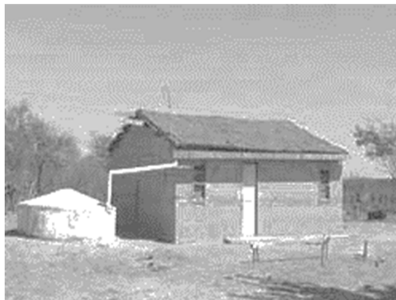
FIGURA 3 – CISTERNA DE PLACA DE CIMENTO
