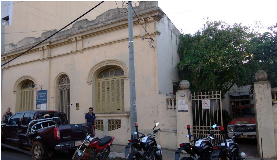
FIGURA 1. EDIFÍCIO DA EX-LA TÉCNICA
